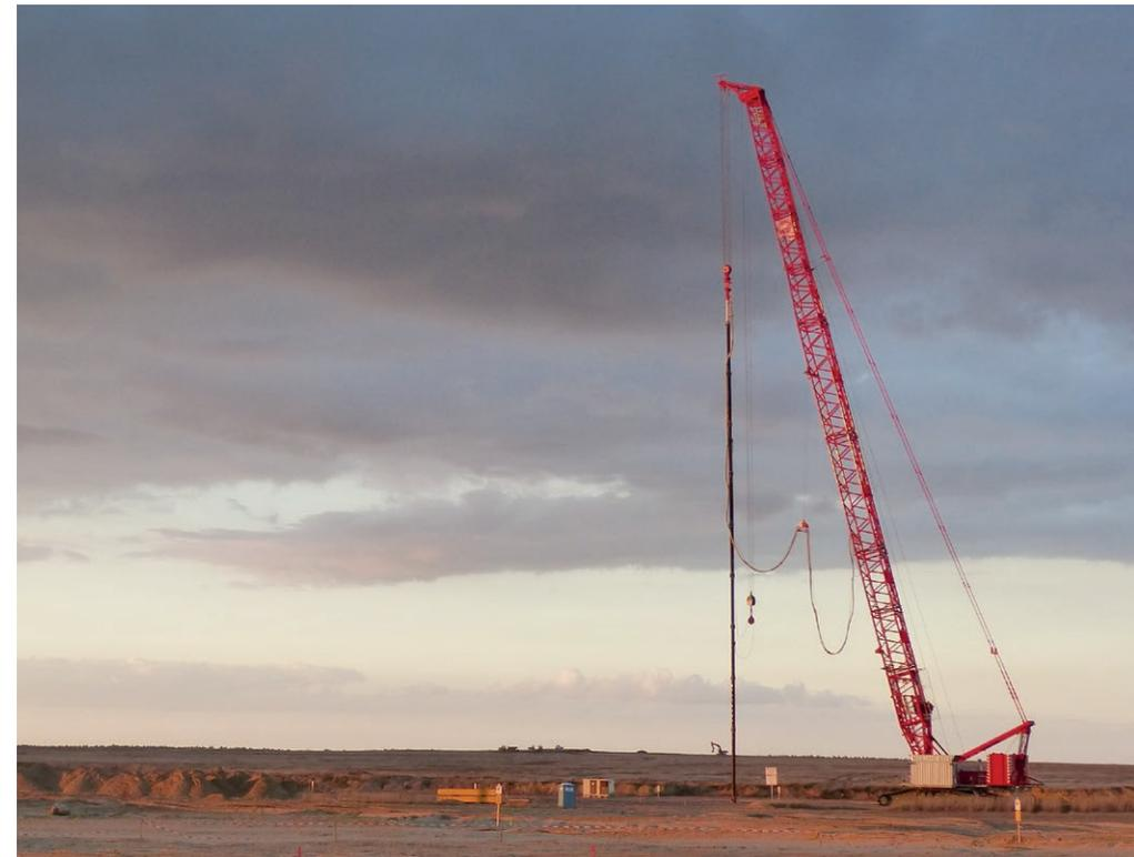
Bei der Prozessautomatisierung von Rütteldruck- und Rüttelstopfverdichtung werden spezielle Vorgabewerte und Arbeitsprozesse durch eine SPS-Steuerung ausgeführt und überwacht. Dabei werden Winden der Trägermaschine, Frequenzumformer, Pumpen, Kompressoren und Ventile der Medienmischanlage gemäß Vorgaben präzise gesteuert. Alle prozessrelevanten Daten werden zusätzlich zur Eigen- und Qualitätssicherung erfasst, der Leistungsabrechnung zugeführt und digital zur Nachweiserbringung gesichert.
